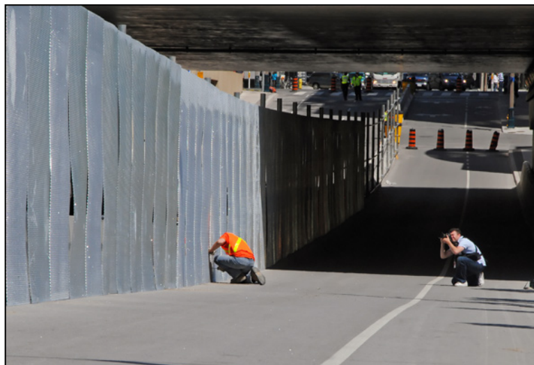
Photo 6 : 8 juin – L'installation de la clôture de sécurité rue Lower Simcoe près du boulevard Bremner. (Photo prise par Tomasz Bugajski)
